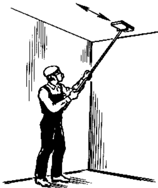
Рис.4. Сглаживание поверхности шарнирной теркой
